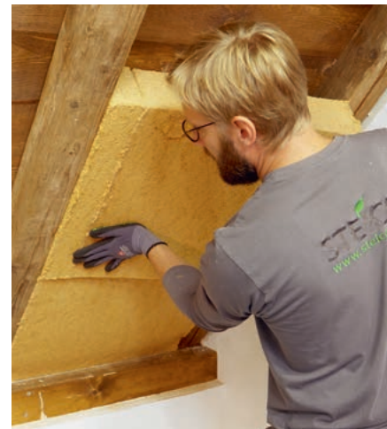
Montaż mat termoizolacyjnych STEICOflex 036 między krokiewiami
